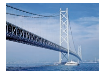
明石海峡大橋
